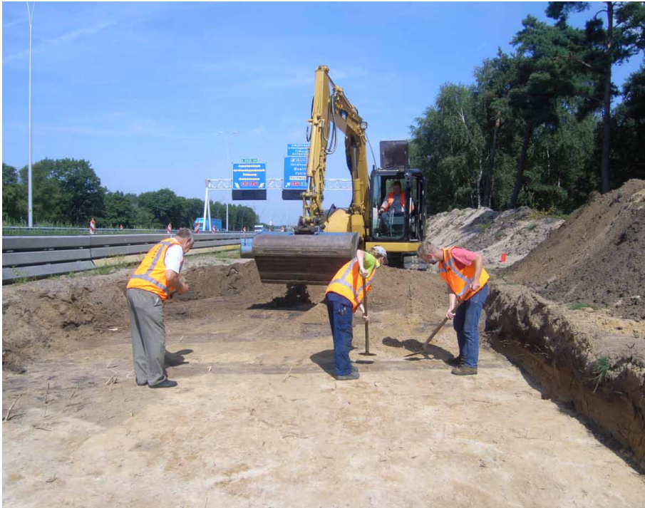
Afb. 5.14. Aanleg van sleuf 6. Foto genomen richting het noordwesten.
